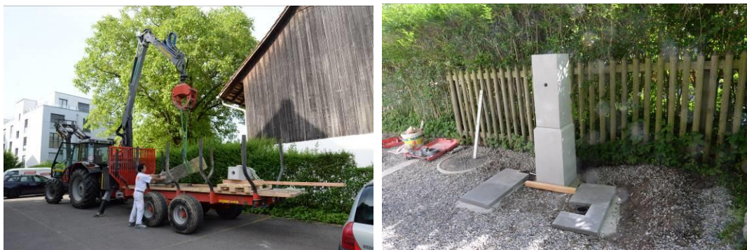
Installation des Brunnens im Aussenraum der Scheune
